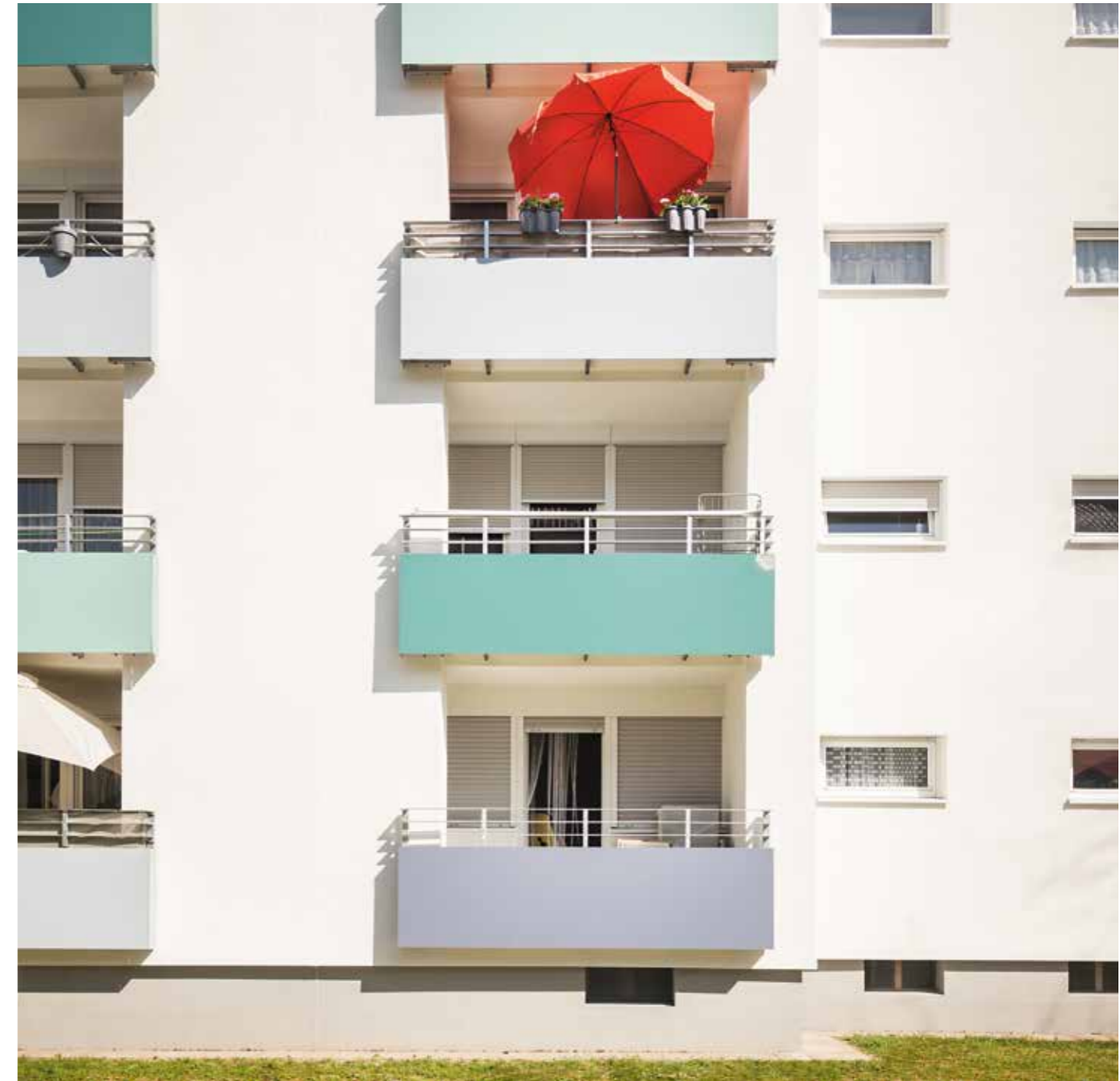
Das im Jahr 2018 sanierte Gebäude in der Tilsiterstraße auf der Schönaun.
