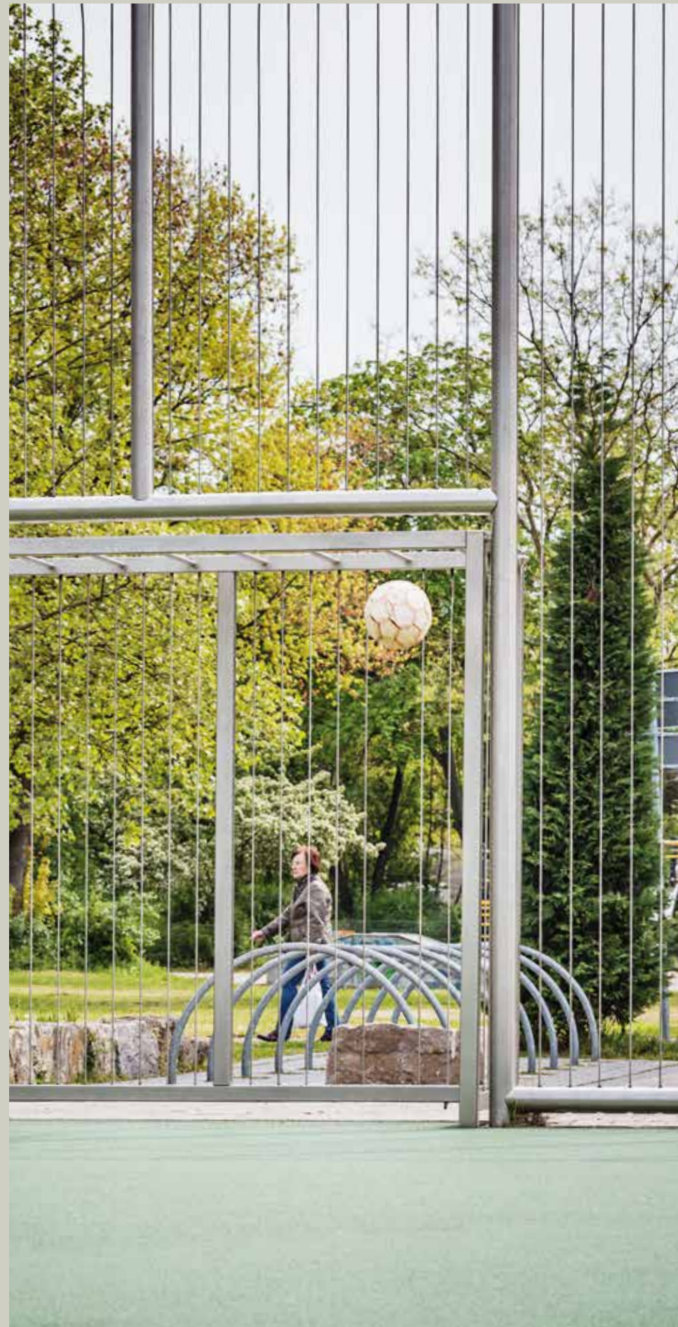
Bolzplatz mit speziellem Lärmschutzzaun im Apenrader Weg.
