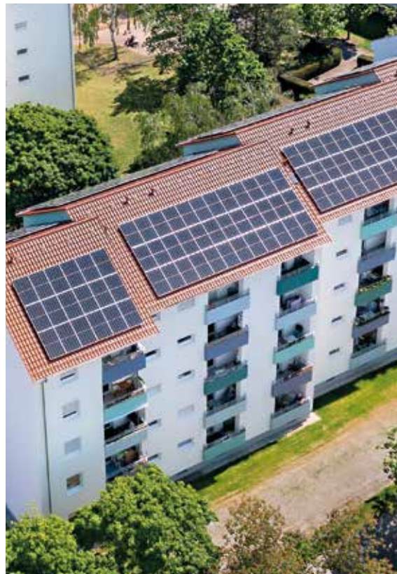
Hier entsteht Ökostrom: Neue PV-Anlagen in der Tilsiterstraße im Stadtteil Schönau.
