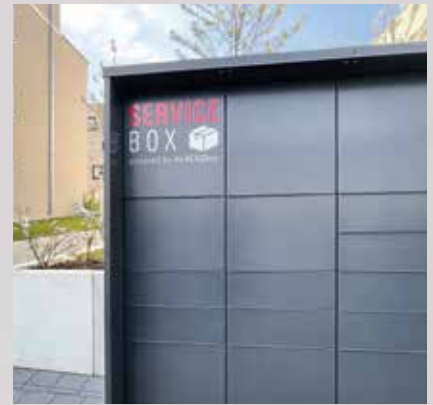
Immer geöffnet: Die Service-Box ist ein Baustein vernetzter Quartiere.
