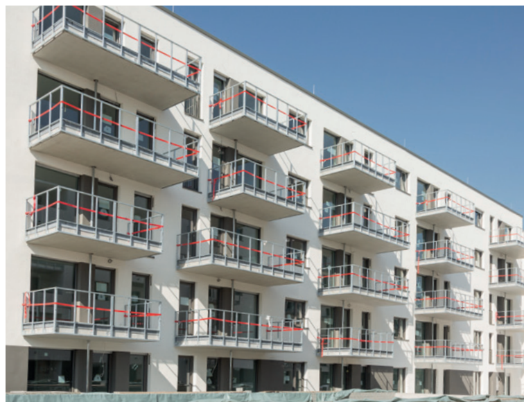
Neubaumaßnahme auf FRANKLIN.
